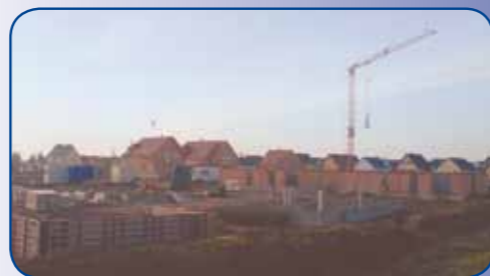
Les résidences «Le Jardin des Muses» et «Les Marquises» sont en cours de construction
