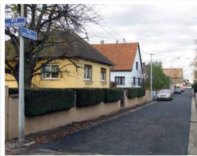
Pose d'un tapis mince rue des Fleurs
