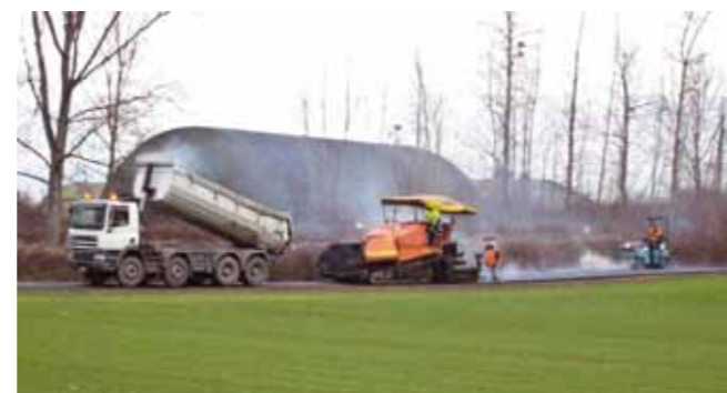
Pose d'un nouvel enrobé sur le chemin longeant l'aéroport: n'hésitez pas à enfourcher vos vélos!
