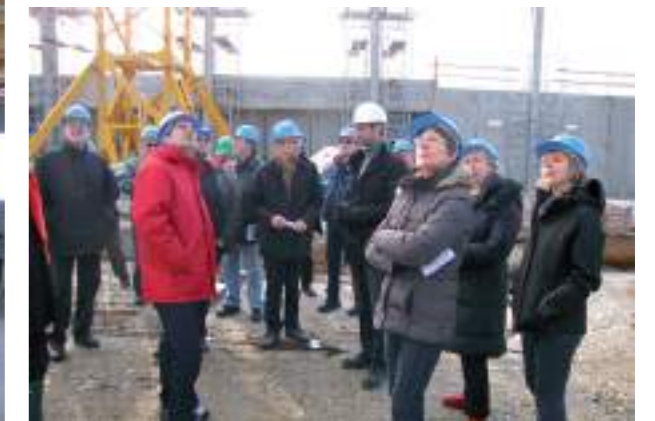
Visite du chantier en février 2013 par le Conseil Municipal sous la conduite de l'architecte Dominique Rambeaud
