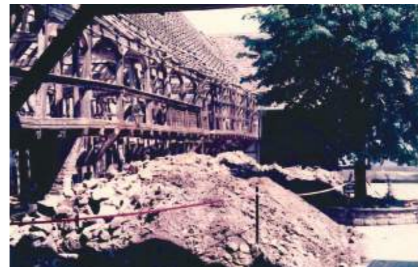
L'hôtel avant son ouverture avec son ossature bois totalement mise à nu pendant les travaux
