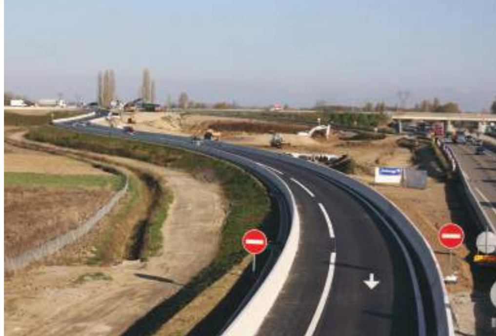
La nouvelle bretelle d'Entzheim (RD 400) vers Colmar (A35) a été mise en service le 31 octobre.
