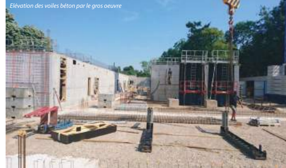
Elévation des voiles béton par le gros oeuvre
