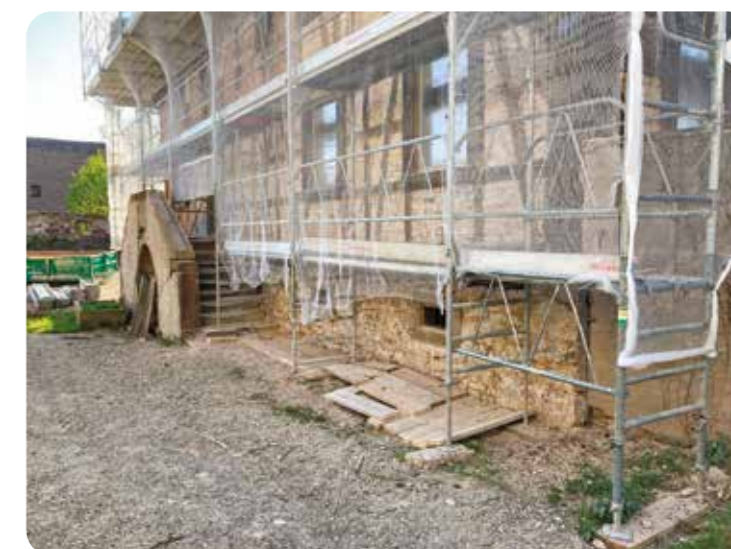
Piquage de l'ancien enduit recouvrant le pan de bois
