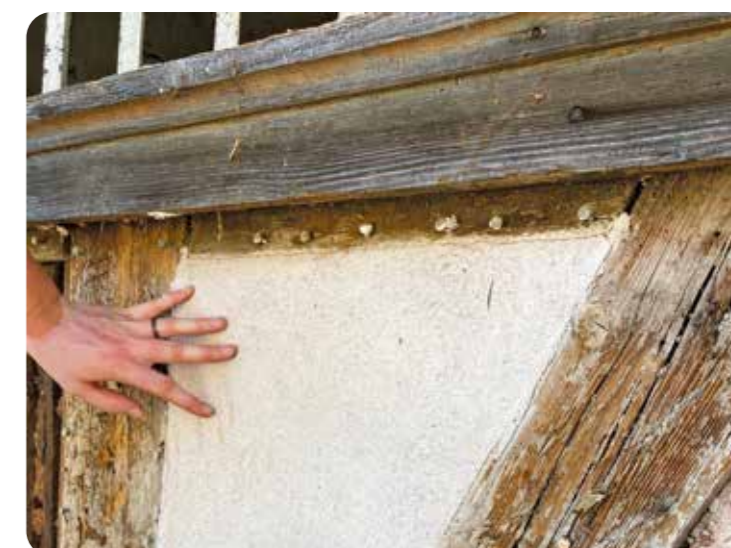
Essai d'enduit à la chaux
