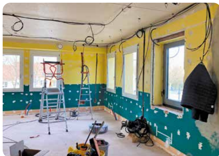
Travaux dans les anciennes salles de classe
