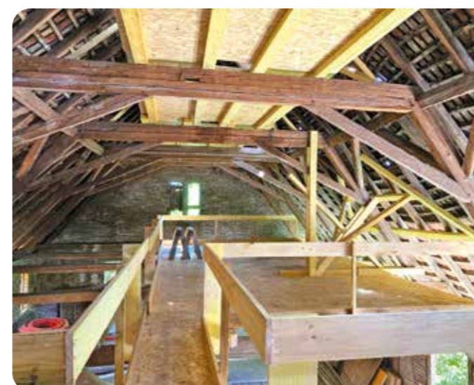
Mise en sécurité de la charpente de la grange
