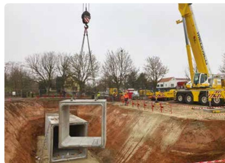
Pose des éléments du bassin en béton préfabriqué
