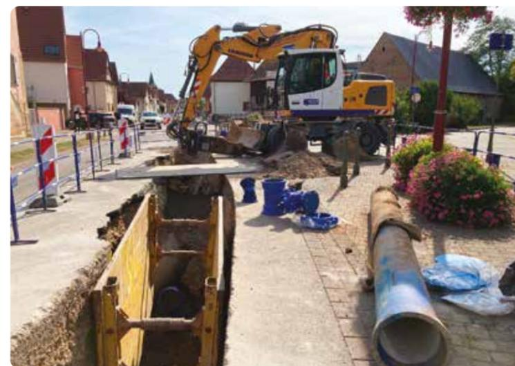
Remplacement de la conduite d'eau potable route de Strasbourg
