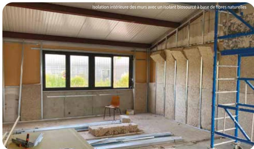
Isolation intérieure des murs avec un isolant biosourcé à base de fibres naturelles
