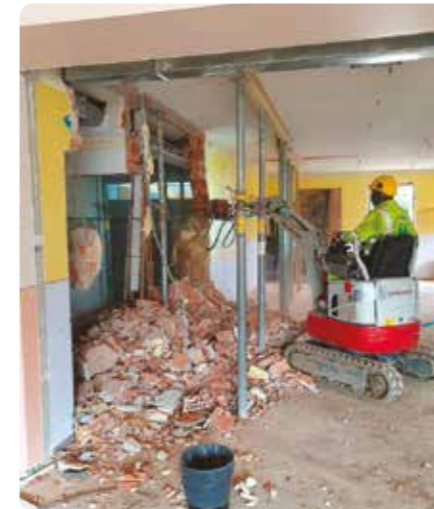
Démolition dans la partie rénovée - 30/10/2020
