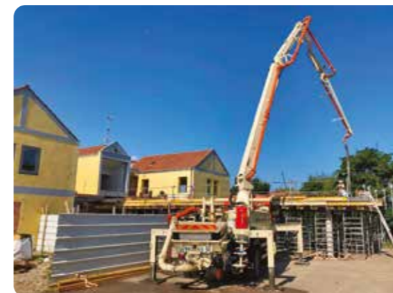
Gros œuvre : réalisation du Préau - 30/07/2021
