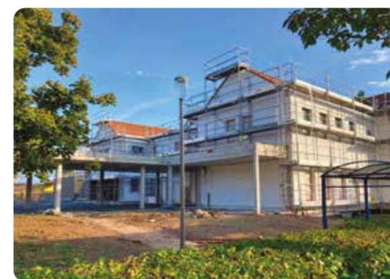
Pose de l'isolation thermique par l'extérieur - 13/10/2021
