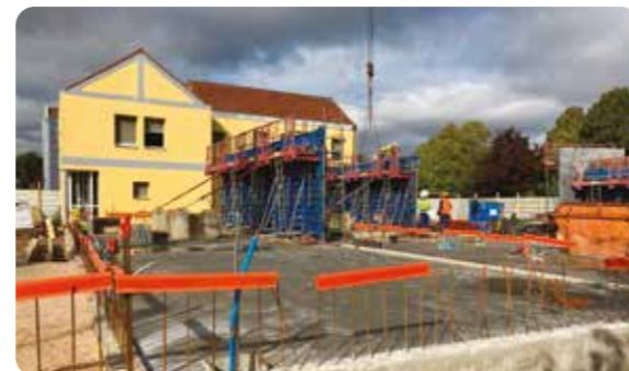
Gros œuvre : coffrage des murs de l'extension - 08/10/2020
