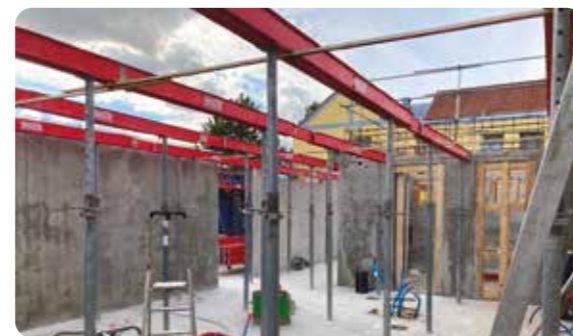
Gros œuvre : réalisation de la dalle haute de l'extension - 14/10/2020
