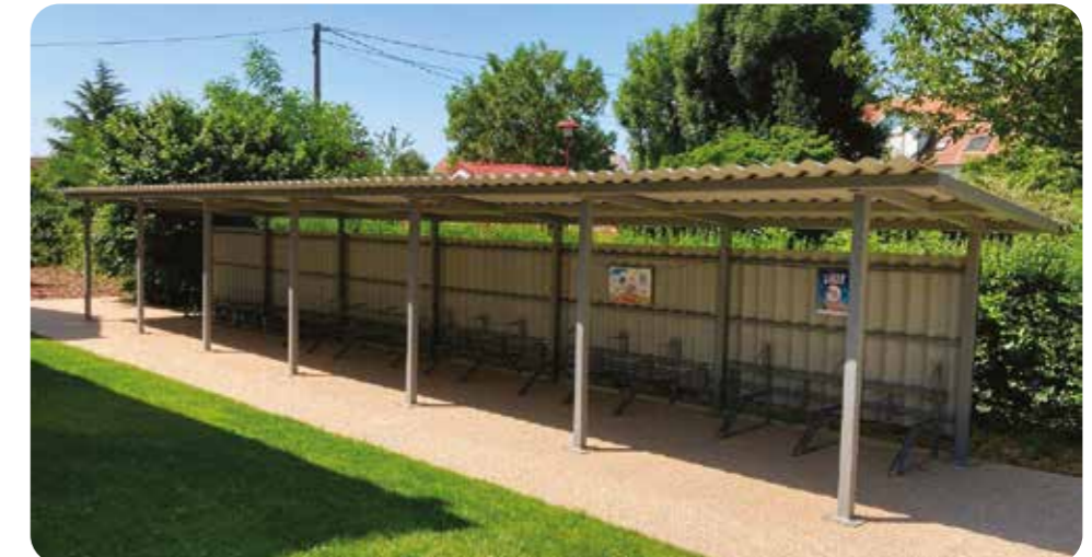
La rénovation de l'école a été l'occasion de créer un nouvel abri à vélo sur mesure pour remplacer les éléments préfabriqués abîmés
