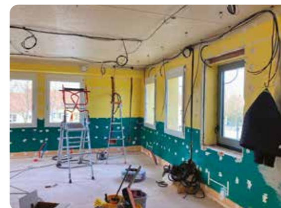
Incorporations électriques dans la future bibliothèque - 17/03/2021
