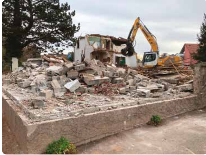
Démolition de la maison du 57 route de Strasbourg
