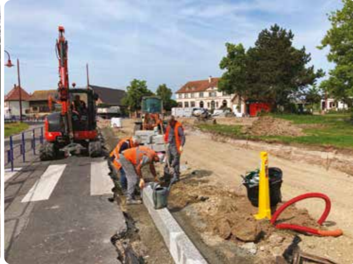
Pose des bordures en granit
