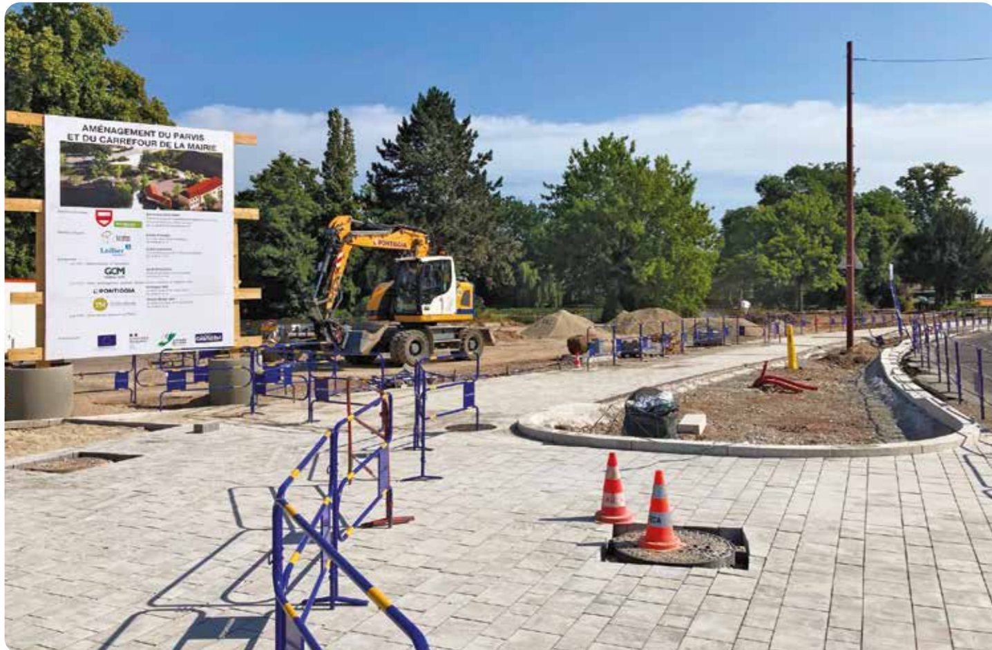
Pose des pavés au carrefour des rues Jacques Humann, de la salle des fêtes et de la route de Strasbourg
