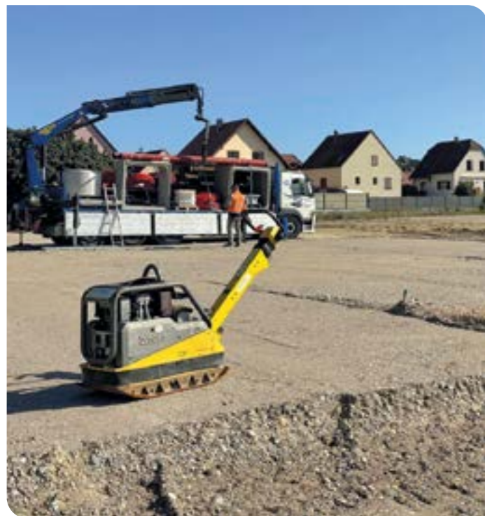
Terrassement de la plateforme
