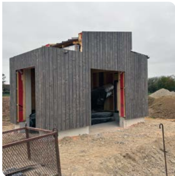
Réalisation du prototype qui sera conservé à l'issue du chantier
