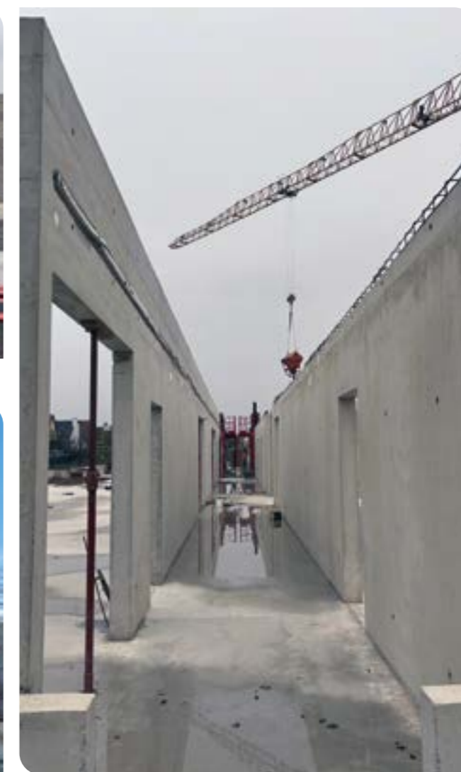
Futur couloir de l'école maternelle
