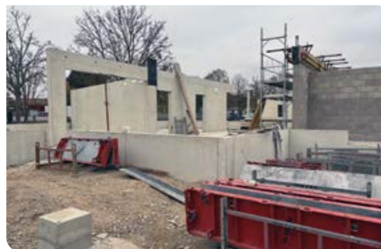
Réalisation des murs de la MAM
