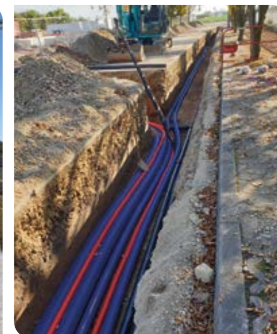
Pose des tuyaux du réseau de chaleur collectif
