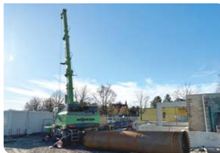
Forage d'un puits pour le réseau de chaleur
