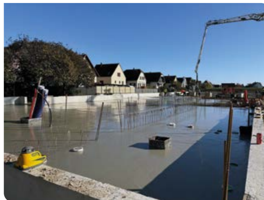
Coulage du dallage de l'école maternelle
