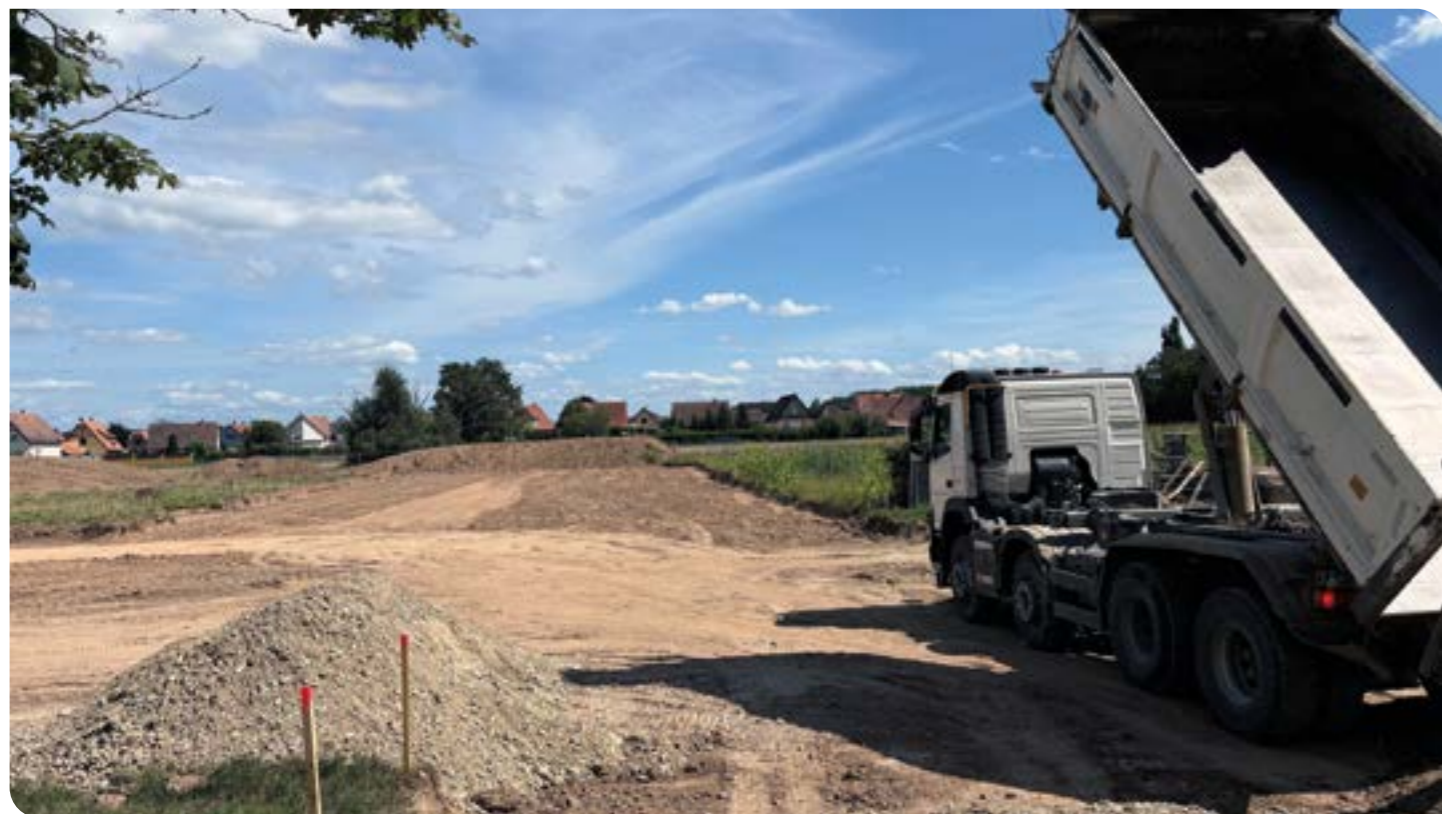
Démarrage du terrassement
